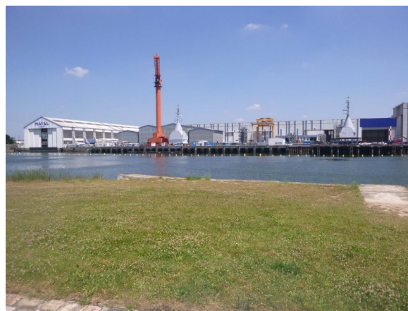
Quai arsenal (Lanester) Source : CEREMA
