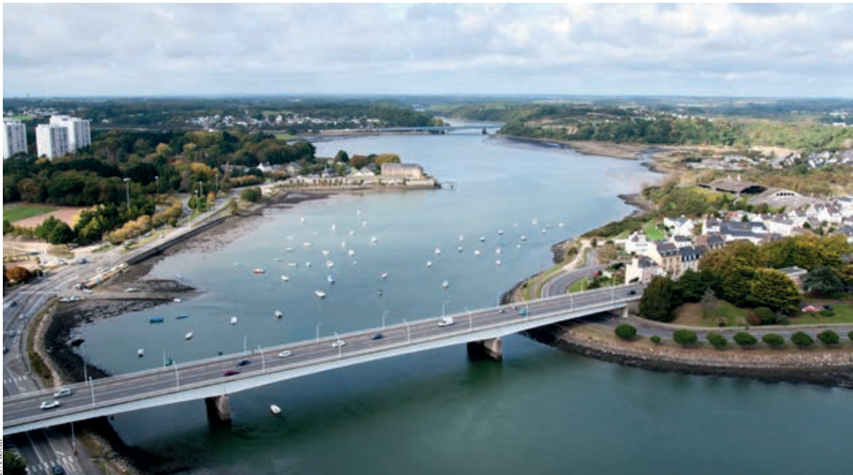
Le pont St Christophe, un réaménagement en cours en collaboration avec Lorient et le département.
